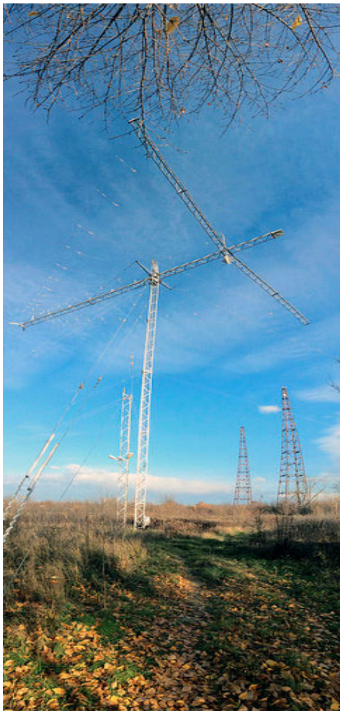
Saftica/Romania 100 kW transmitter for Radio España Independiente 1956-1977
